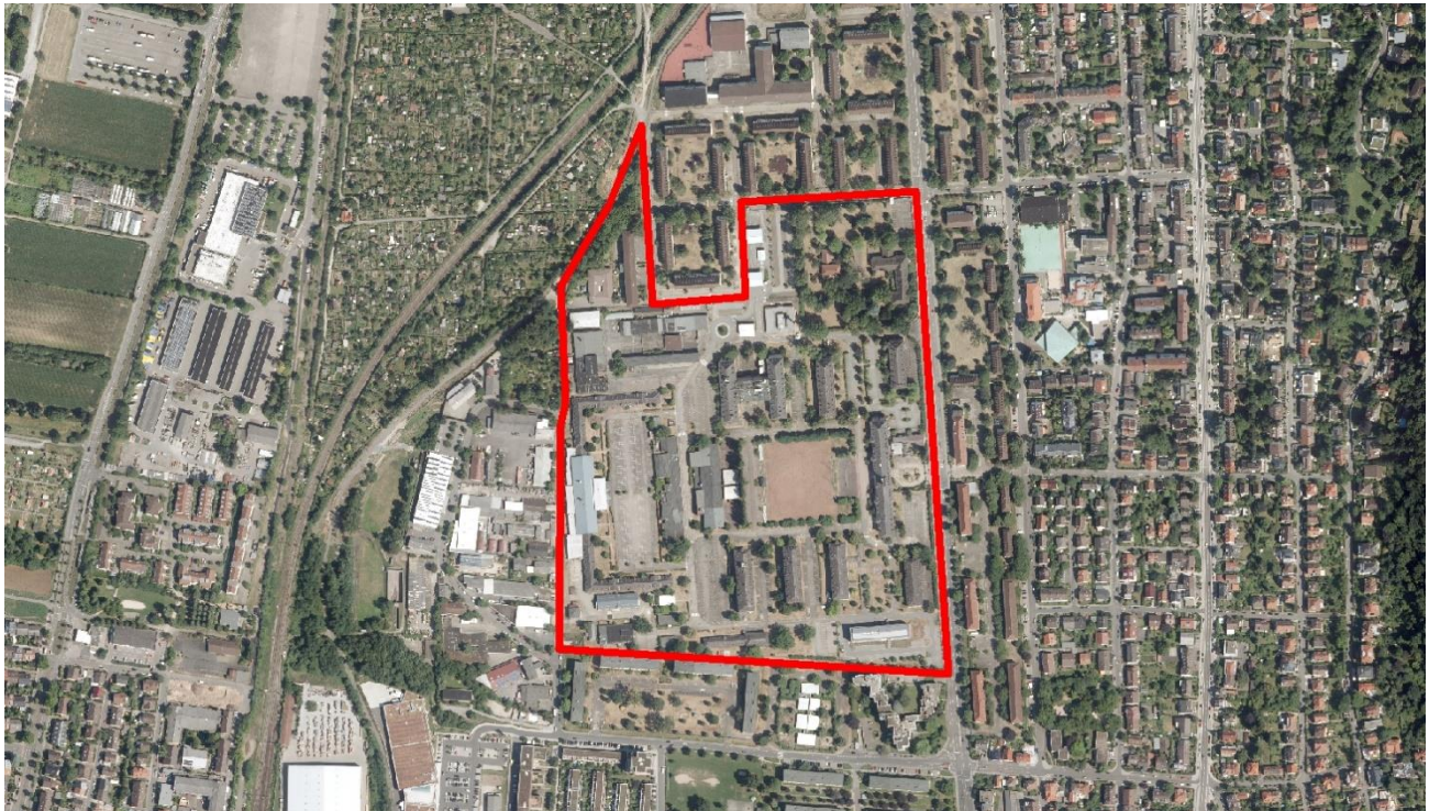
Abbildung 1: Gebäudebestand im Bereich der Änderungsflächen
